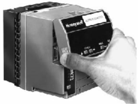
Рис. 9. Установка модуля дисплея с клавиатурой.
